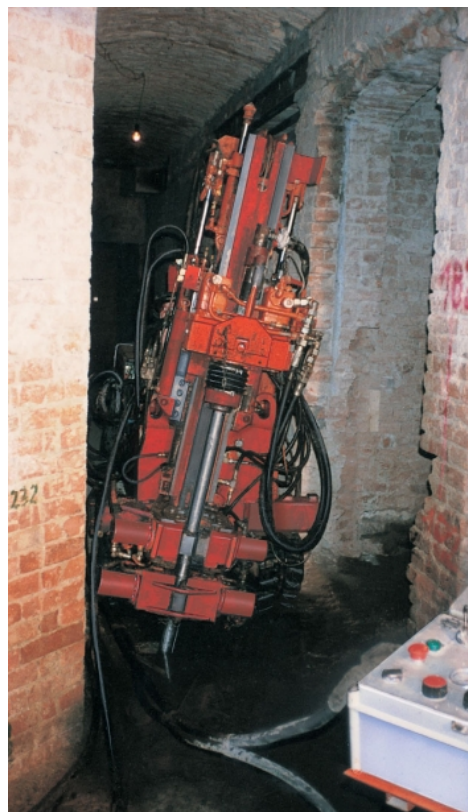
Obrázek 4 - Provádění injektáže ve stísněných prostorách
